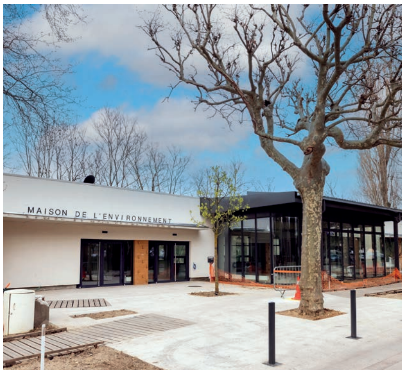
La Maison de l'Environnement, l'un des projets phares du mandat municipal 2020-2026, va prochainement ouvrir ses portes.
