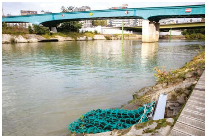
Le filet nasse installé à Maisons-Alfort permet de piéger les déchets.
