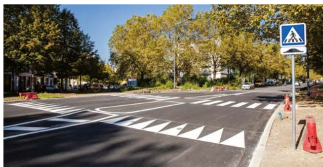
Les travaux d'aménagement de sécurité réalisés avenue Léon Blum, au niveau du carrefour avec les rues Jean Jaurès et Pelet de la Lozère.
