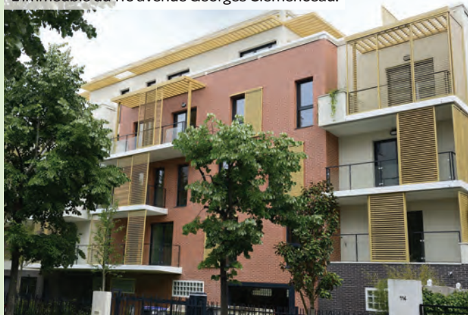
L'immeuble du 116 avenue Georges Clemenceau.
