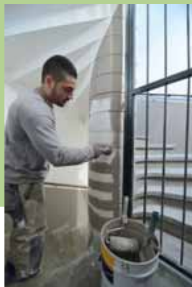
Escalier de la résidence Berlioz
