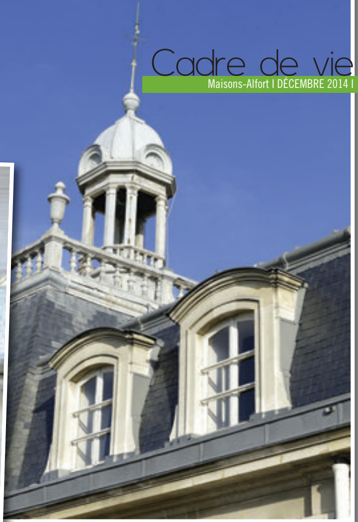
Réfection partielle de la couverture en zinc et des ardoises abîmées de la toiture de l'Hôtel de Ville
