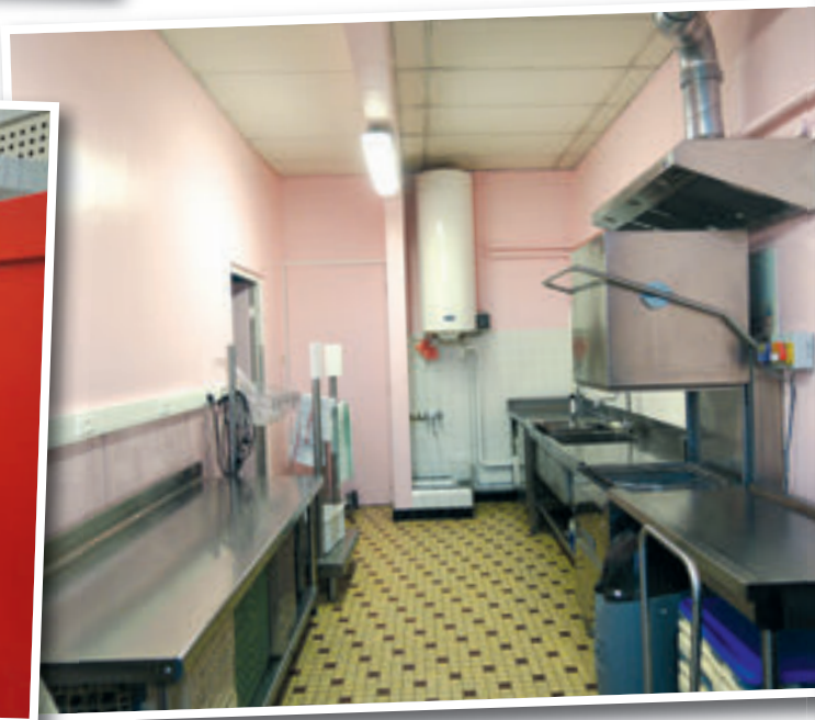
Remise en peinture de l'office-laverie de l'école élémentaire des Planètes.
