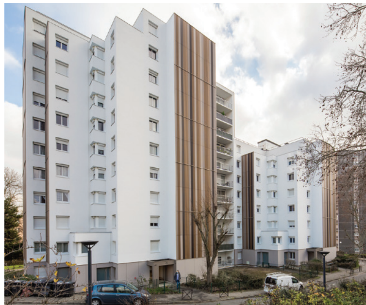
La résidence Berlioz III a bénéficié d'un ravalement de façades.
