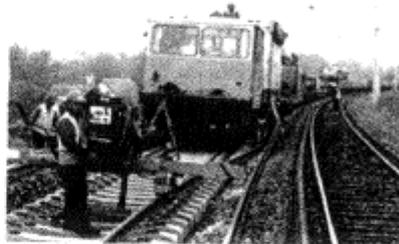
Longs Rails soudés sur traverses béton
