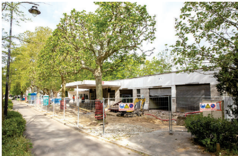
Les travaux de réhabilitation de l'ancienne station-service, qui après une transformation complète, laissera place à la Maison de l'Environnement, ont débuté.
