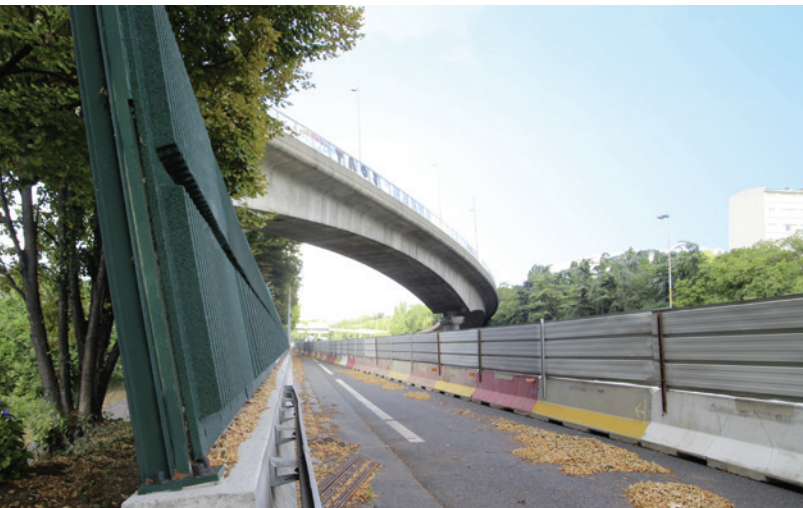
Le renforcement des protections phoniques le long des autoroutes A4 et A86 se poursuit.
