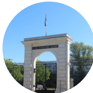
L'école nationale vétérinaire d'Alfort Dans le quartier d'Alfort
